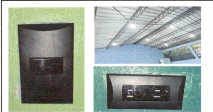
Foto 9 Reparacion de sistema electrico, compra y colocacion de suministros de energia electrica (cable, plafonera y lamparas)
