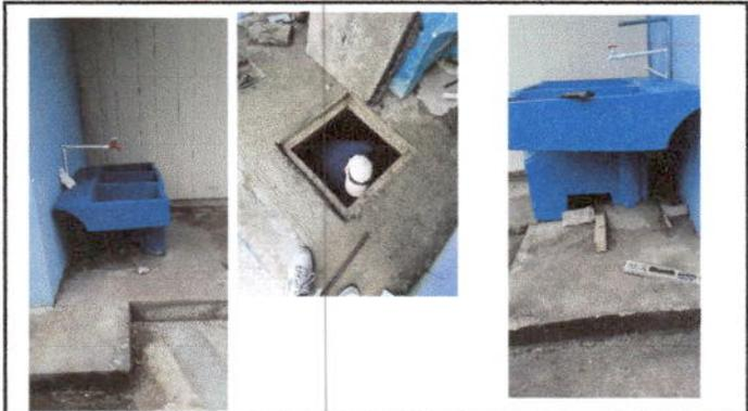
Foto 8 Reparacion de red de drenaje, red de agua potable, limpieza de fosa septica de 4m3, compra de pilas y reparacion de drenaje para pilas.
